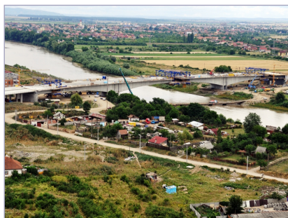
Pod peste raul Mures - Vedere din aer
