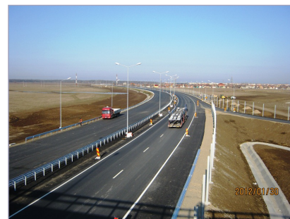
Sectiune din autostrada aproape finalizata
